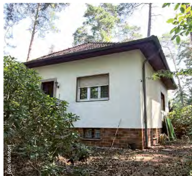
Zwangssanierung oder Abriss und klimaneutraler Neubau? In Berlin darf das der Eigentümer aufgrund der Zweckentfremdungsverbot-Verordnung nicht mehr frei entscheiden.
